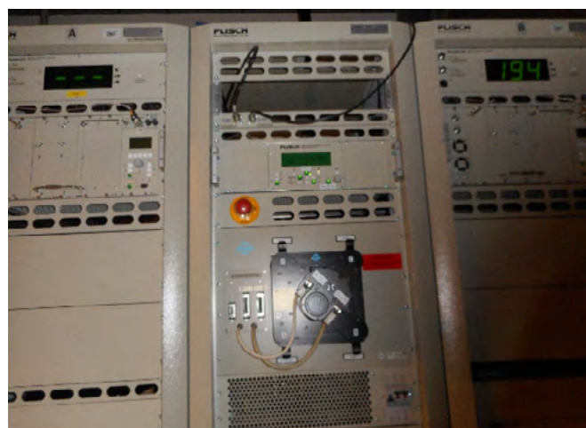
9. ábra A Széchenyi-hegyi, Plisch gyártmányú DAB-adó (forrás: Digitális rádiózás a világban és nálunk, HTE előadás, szerző: Balla Éva)
