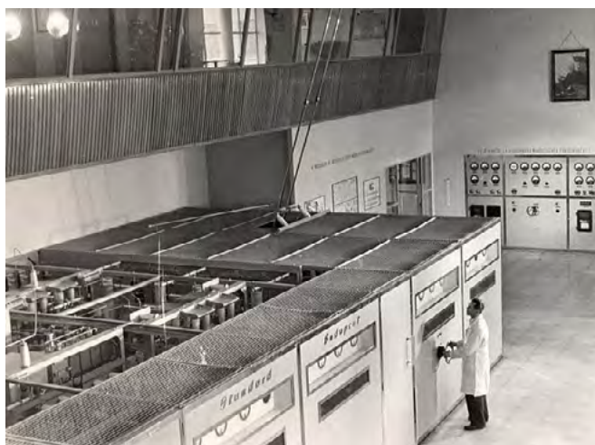
25. ábra A Szolnoki adóépület az önsugárzó antennatoronnyal és az adóterem a 135 kW-os Standard adóval
