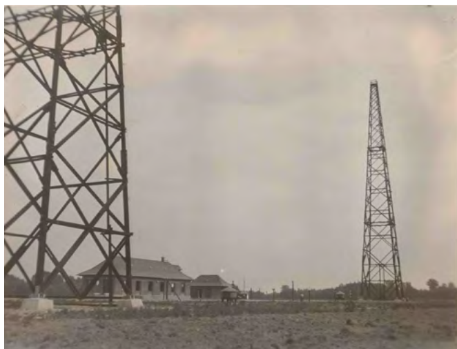
12. ábra A magyaróvári rádióállomás épülete és antennatornyai
