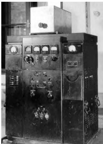
23. ábra BC 610 típusú amerikai katonai adóberendezés
