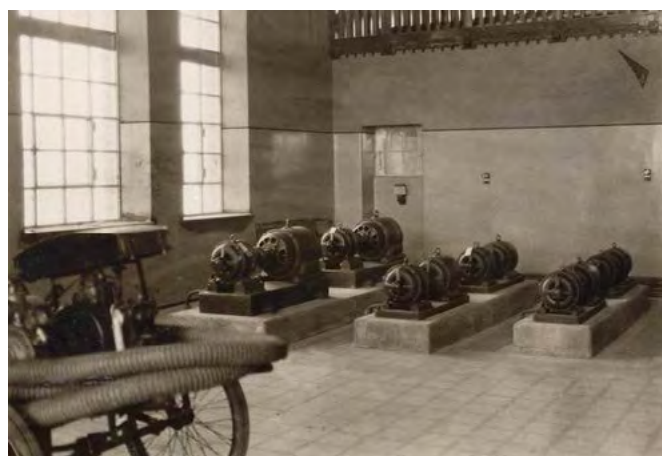
6. ábra A forgógépek terme (rácsgép, fűtőgép stb.) Lakihegyen
