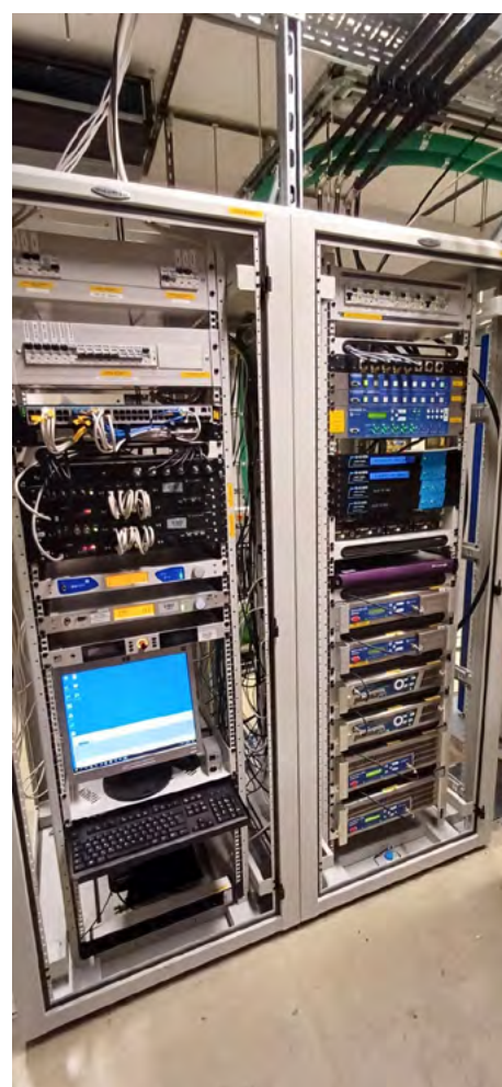
14. ábra A szegedi WorldCast adó „N+1” tartalékolási elrendezése (ábra forrása: Bíró Dániel)
