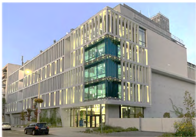
12.ábra Az NMHH Mérőszolgálatnak otthont adó, új műszaki épülete
